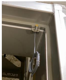
Capteur inductif pour indication position de la porte étanche (ouverte ou fermée) positionné sur son support sur cadre.
